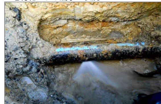
▼老朽化による漏水の状況
