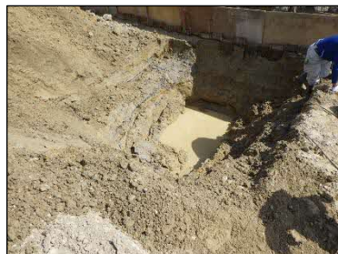
掘削時湧き水の発生を確認
