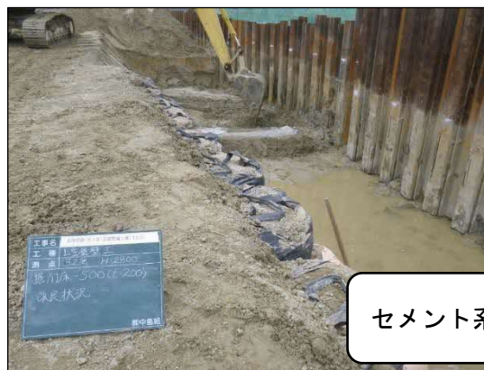
キャスポル（簡易支持力測定器）にて地盤支持力を測定し、セメント系固化材の添加量を算出
