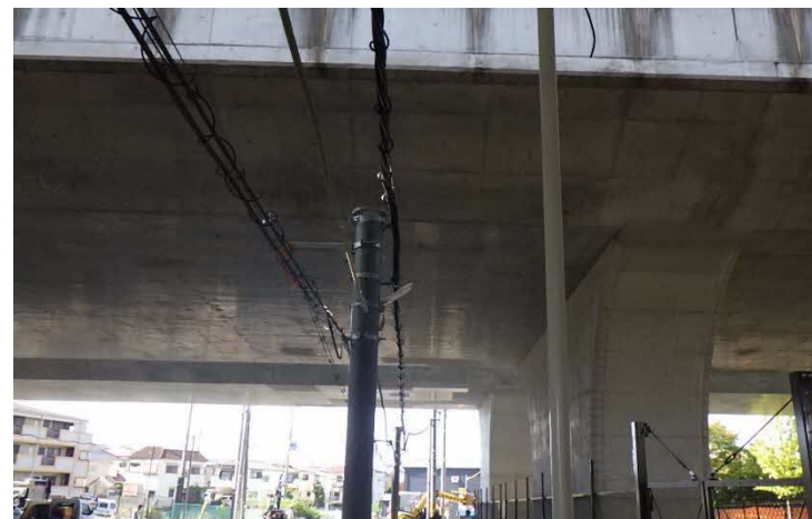
街路灯の移設
