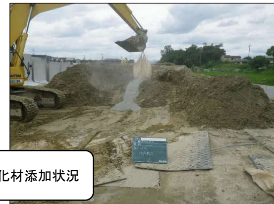
キャスポル（簡易支持力測定器）にて地盤支持力を測定し、セメント系固化材の添加量を算出
