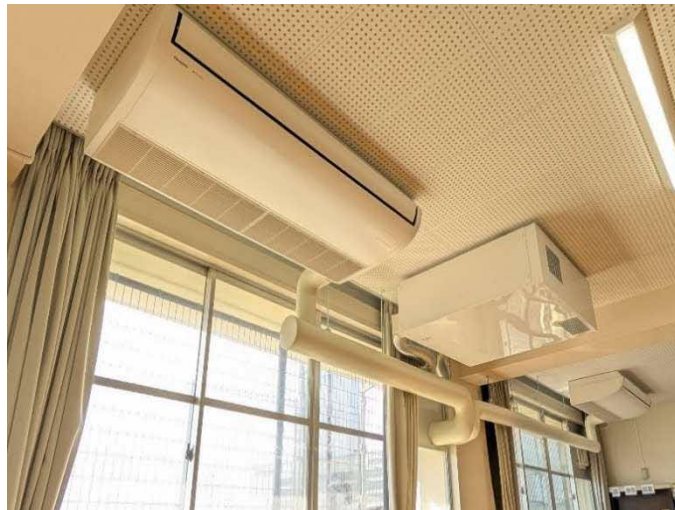
■室内機、全熱交換器の設置状況
