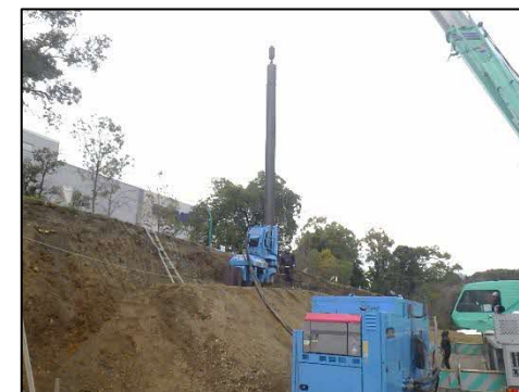
鋼矢板圧入状況
