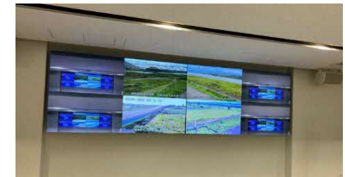
災害対策本部室内に常設のマルチモニター（守山市）
