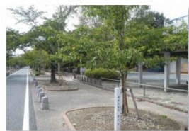
街路樹の再整備（豊川市）
