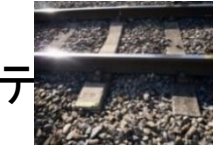
線路設備の修繕
