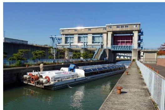
毛馬閘門を通過する様子
