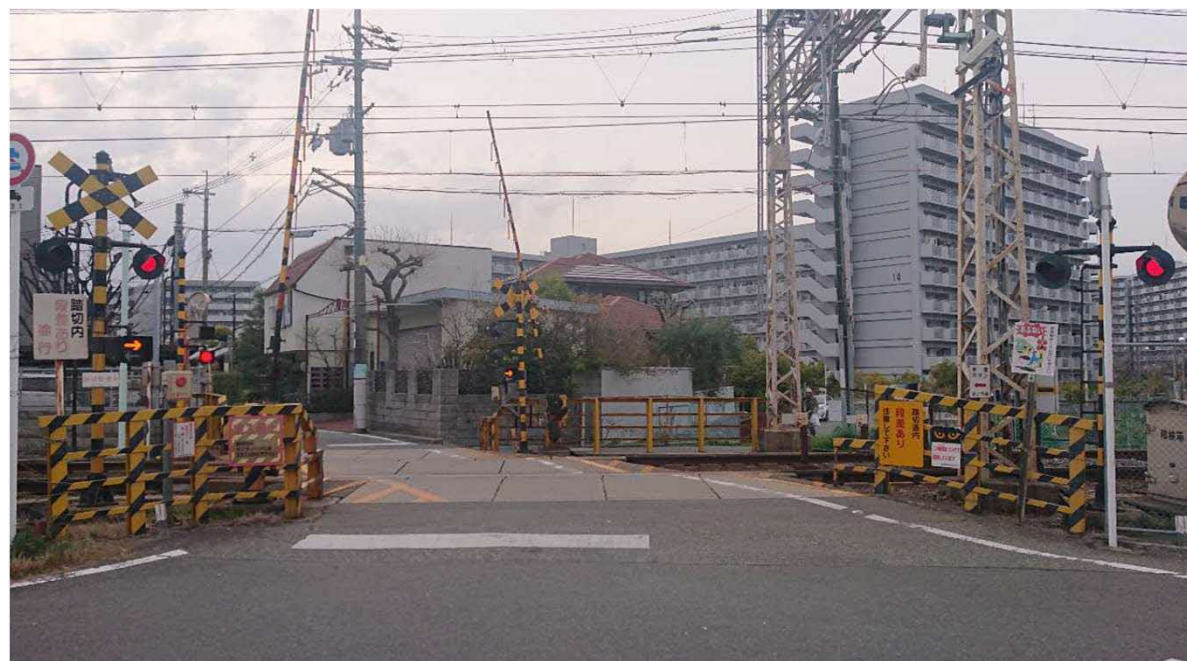
前川踏切道（更新前）
