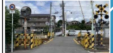
村野2号踏切（市施工）
