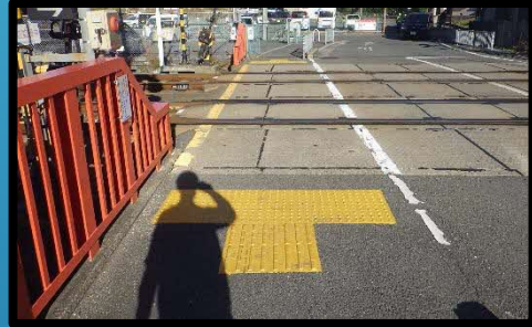
星ヶ丘2号踏切 (市施工)
