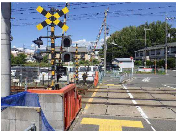
星ヶ丘 2号踏切道(更新前)
