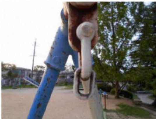
シャックル外れ状況
