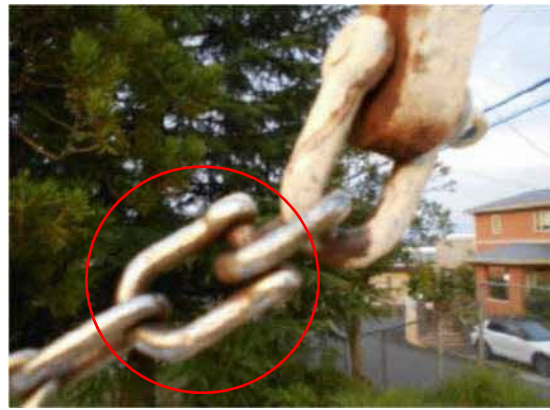
同形状のシャックルの使用状況
