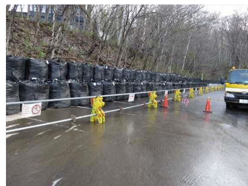
応急復旧完了
