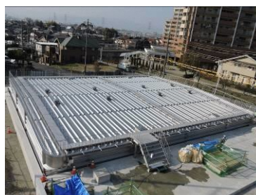
<津田低区配水場3号池>
