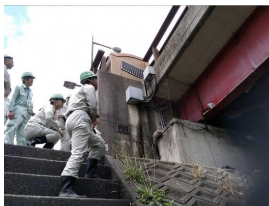
橋梁点検訓練
