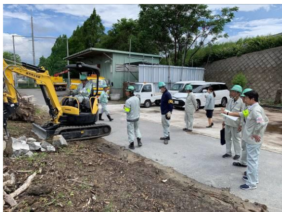
道路啓開（救援ルート確保）訓練
