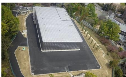
<鷹塚山配水場>
