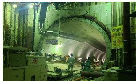
＜築造中の楠葉雨水貯留管＞
