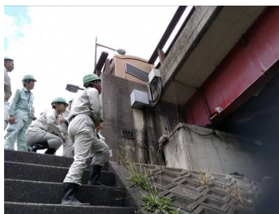
橋梁点検訓練
