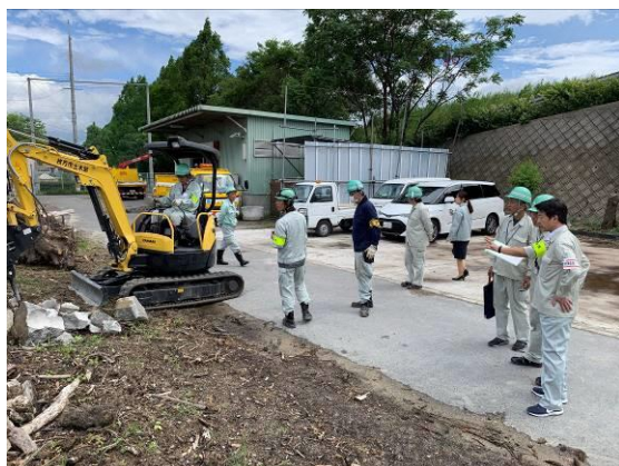
道路啓開（救援ルート確保）訓練
