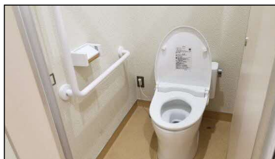
改修工事後のトイレ
