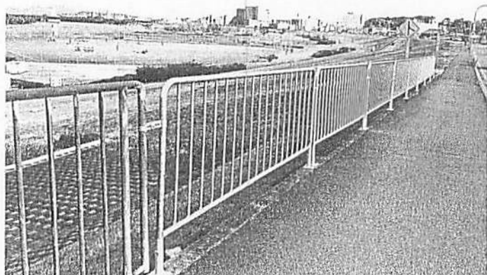
方河川公園周辺の歩道に河川敷転落防止安全柵の延長を25mにわたり設置できました。(令和3年2月)
