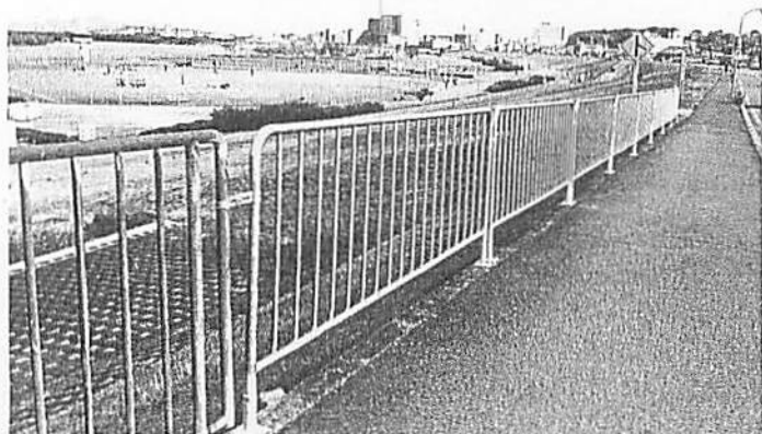
上方河川公園周辺の歩道に河川敷転落防止安全柵の延長を25mにわたり設置できました。
