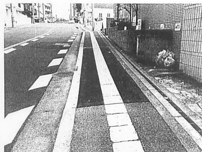
京阪文化会館周辺ローソン手前歩道の傾斜解消整備完了(昨年12月)
