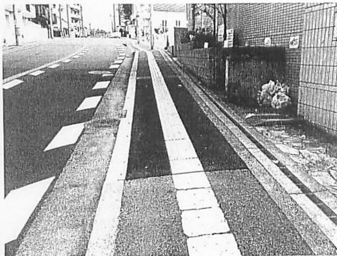
東中振2丁目 京阪文化会館周辺ローソン手前歩道の傾斜解消整備完了(昨年12月)
