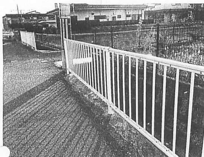
出口3丁目水路の転落防止安全柵(2ヶ所)が設置して頂きました。(昨年11月)
