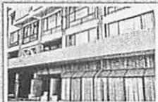
労働組合事務所が入る 職員会館
