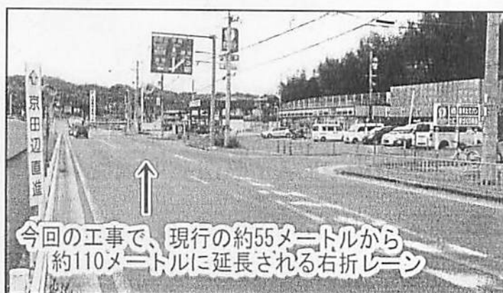
東側右折レーンの延長工事が始まった 杉1丁目交差点
