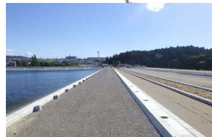
<牧野長尾線・長尾杉線 道路整備工事>
