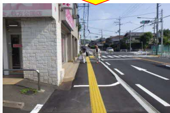
<歩道拡幅整備>
