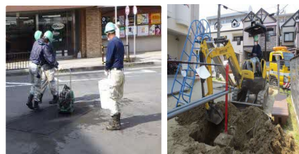
<直営の道路補修> <老朽化遊具の更新>
