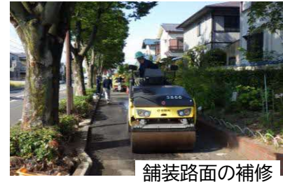
舗装路面の補修
