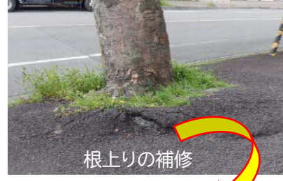
舗装路面の補修
