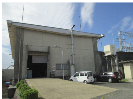
<北部ポンプ場外観>
