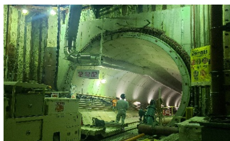
<築造中の楠葉雨水貯留管>
