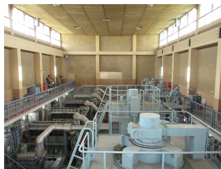
<北部ポンプ場内部>
