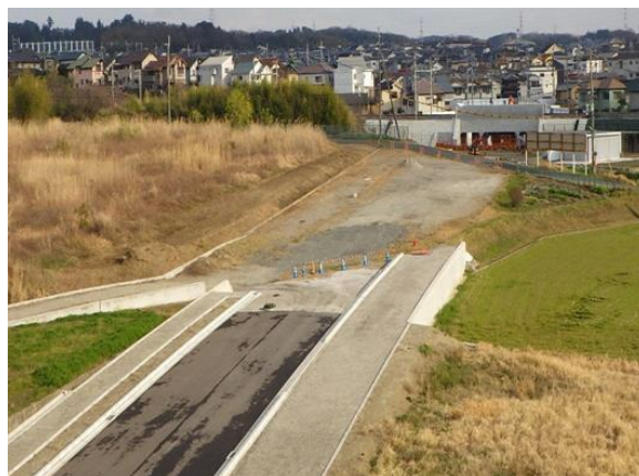
牧野長尾線 道路整備工事
