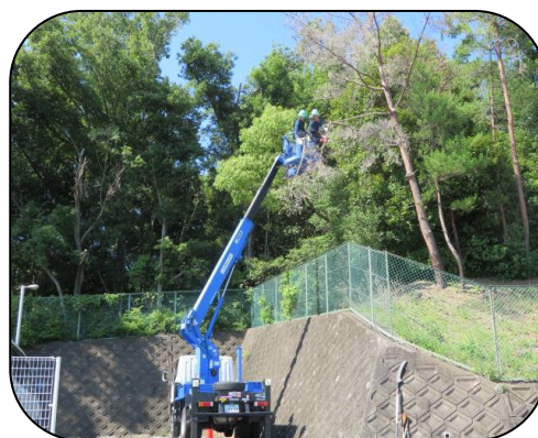
高所作業車による緑地の樹木剪定
