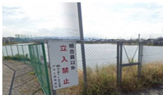
写真5 安全柵の設置例（今池）
