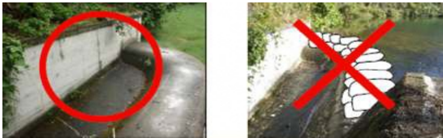
写真4 洪水吐流入部
