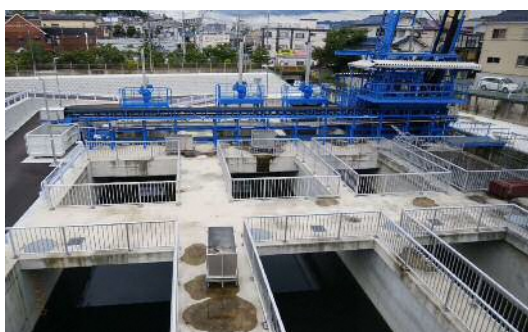
図3. 4 完成した溝谷川ポンプ場の沈砂池(左)と除塵設備(右)
