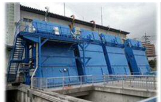
図3. 4 完成した溝谷川ポンプ場の沈砂池(左)と除塵設備(右)
