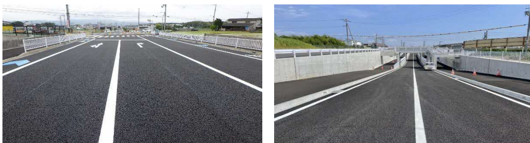
（完成後 写真）都市計画道路牧野長尾線（6工区）
