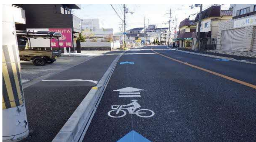
（完成写真）長尾船橋線
