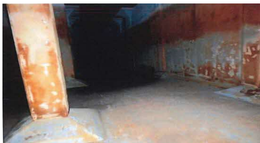
(写真 工事前) 津田低区配水場1号
