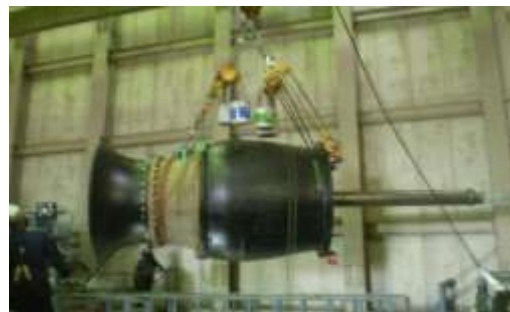
ポンプ分解・点検後
