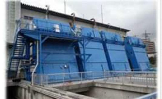
図3. 4 完成した溝谷川ポンプ場の沈砂池(左)と除塵設備(右)
