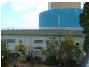
北山配水場 (20kW)
