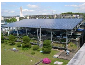
中宮浄水場 (60kW)
