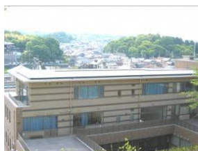
南部生涯学習市民センター (20kW)
