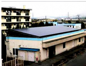
中宮浄水場 (40kW)
