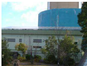
北山配水場 (20kw)
