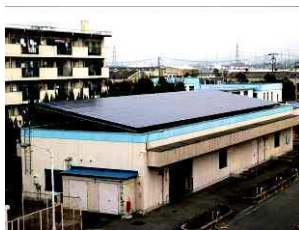
中宮浄水場 (40kw)
