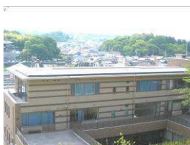
南部生涯学習市民センター (20kw)
