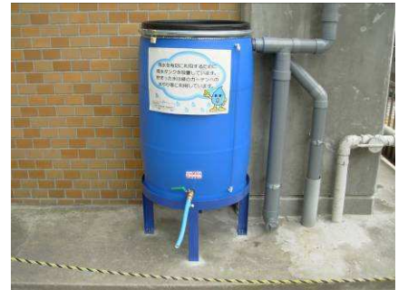
市役所本庁舎に設置した雨水タンク
