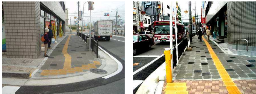
交通バリアフリー枚方市駅前線道路整備工事
