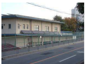
田口山配水場 (20kw)
