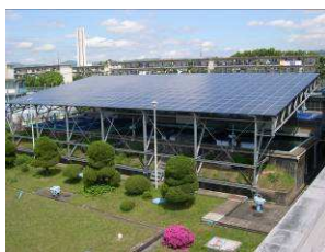
中宮浄水場 (60kw)
