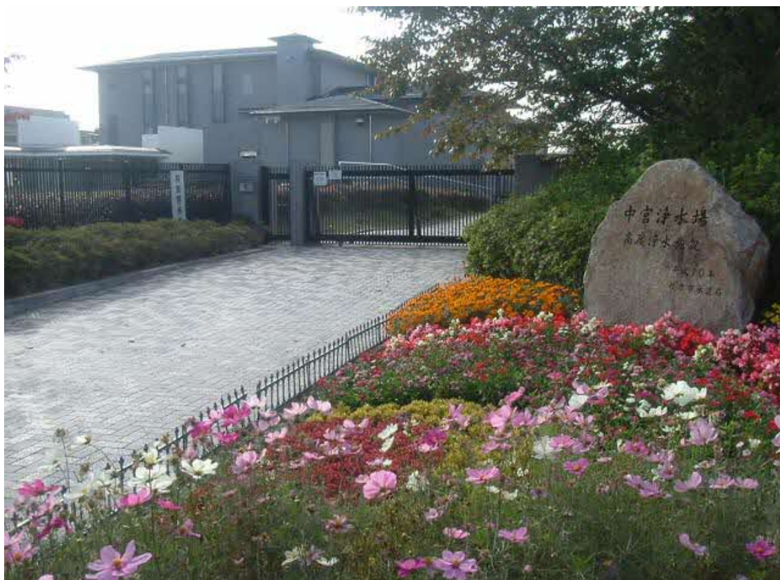
(写真) 中宮浄水場高度浄水施設
