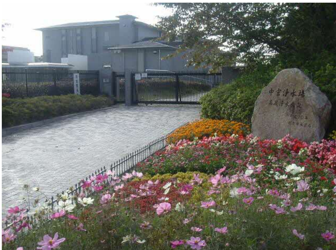
(写真) 中宮浄水場高度浄水施設
