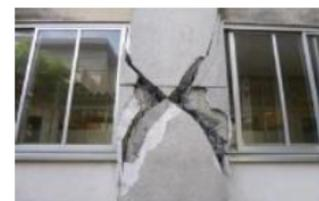
耐震化未完了の建物が大規模地震で甚大な被害を受けた例
