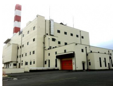
穂谷川清掃工場
