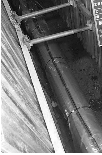
水道管路工事
