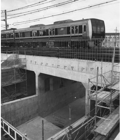
工事中のJRアンダーパスの様子 (写真は都市計画道路牧野長尾線の整備事業での鉄道とのアン
