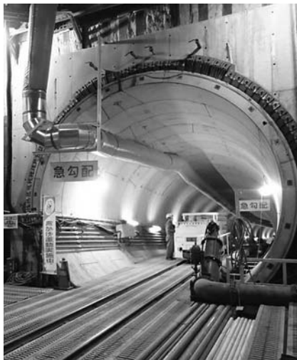
楠葉雨水貯留管整備工事の様子
