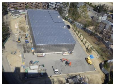
<鷹塚山配水場>
