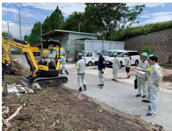
道路啓開（救援ルート確保）訓練
