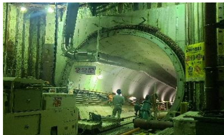
＜築造中の楠葉雨水貯留管＞
