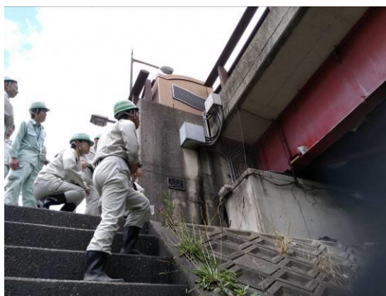
橋梁点検訓練
