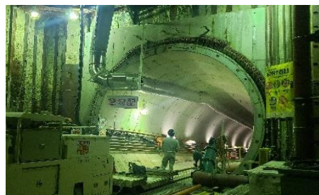
<築造中の楠葉雨水貯留管>
