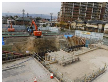
<津田低区配水場3号池>
