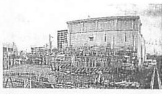
新安居川ポンプ場 (2019/12/12 撮影)
