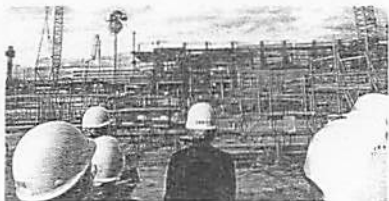
↑工事中の枚方市総合文化芸術センター
