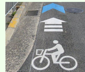
大阪府自転車通行空間法定外表示実施要領(改定版)の法定外路面表示のイメージ(摂津市)
