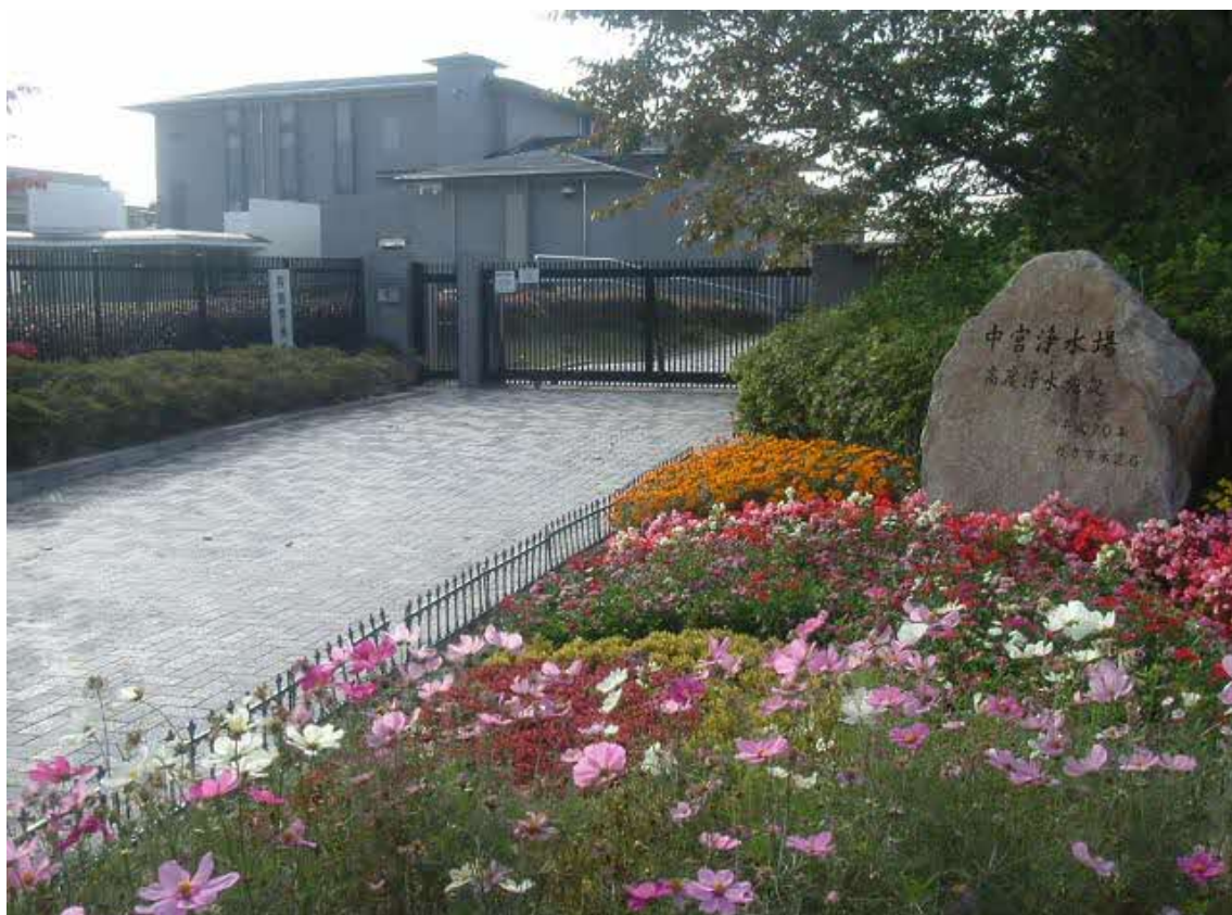
(写真) 中宮浄水場高度浄水施設
