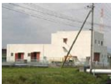
出口汚水中継ポンプ場(出口6丁目)
