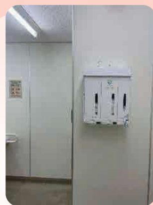
市役所本館 女子トイレ
