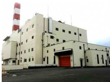
穂谷川清掃工場
