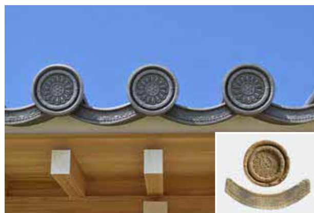
築地塀の軒先の様子（再現軒先瓦と出土軒先瓦）
