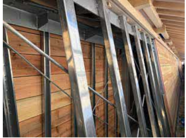
内部はこのように空洞です。
