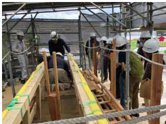
工事の様子を市民に公開しました。
