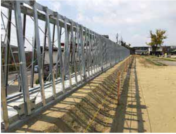
全長 120 mを鉄骨で組んでいます。
