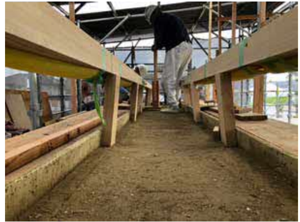
ひたすら搗き固めます。
