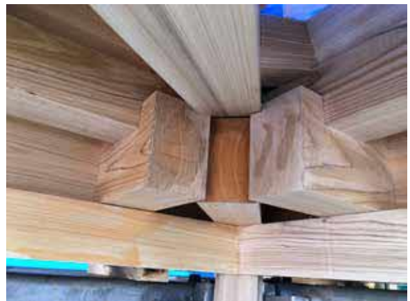
屋根の木工事でも、日本古来の技術が駆使されています。
