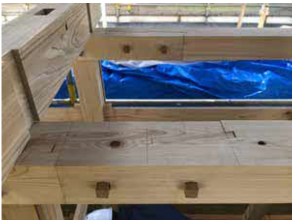
わかりますでしょうか？木材と木材を繋ぐ継ぎ手にも工夫が見てとれます。
