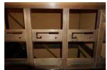
階段手すりの鍵の透彫り
