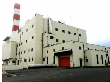
穂谷川清掃工場
